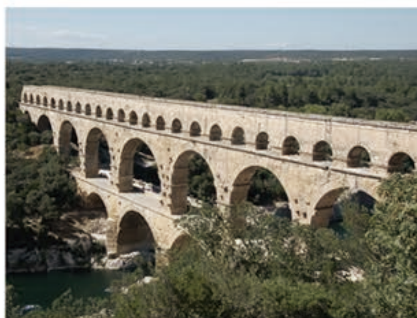
▲ ガール水道橋
