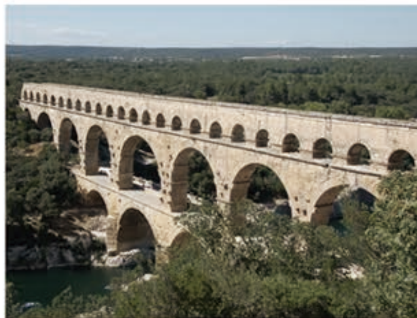
▲ ガール水道橋
